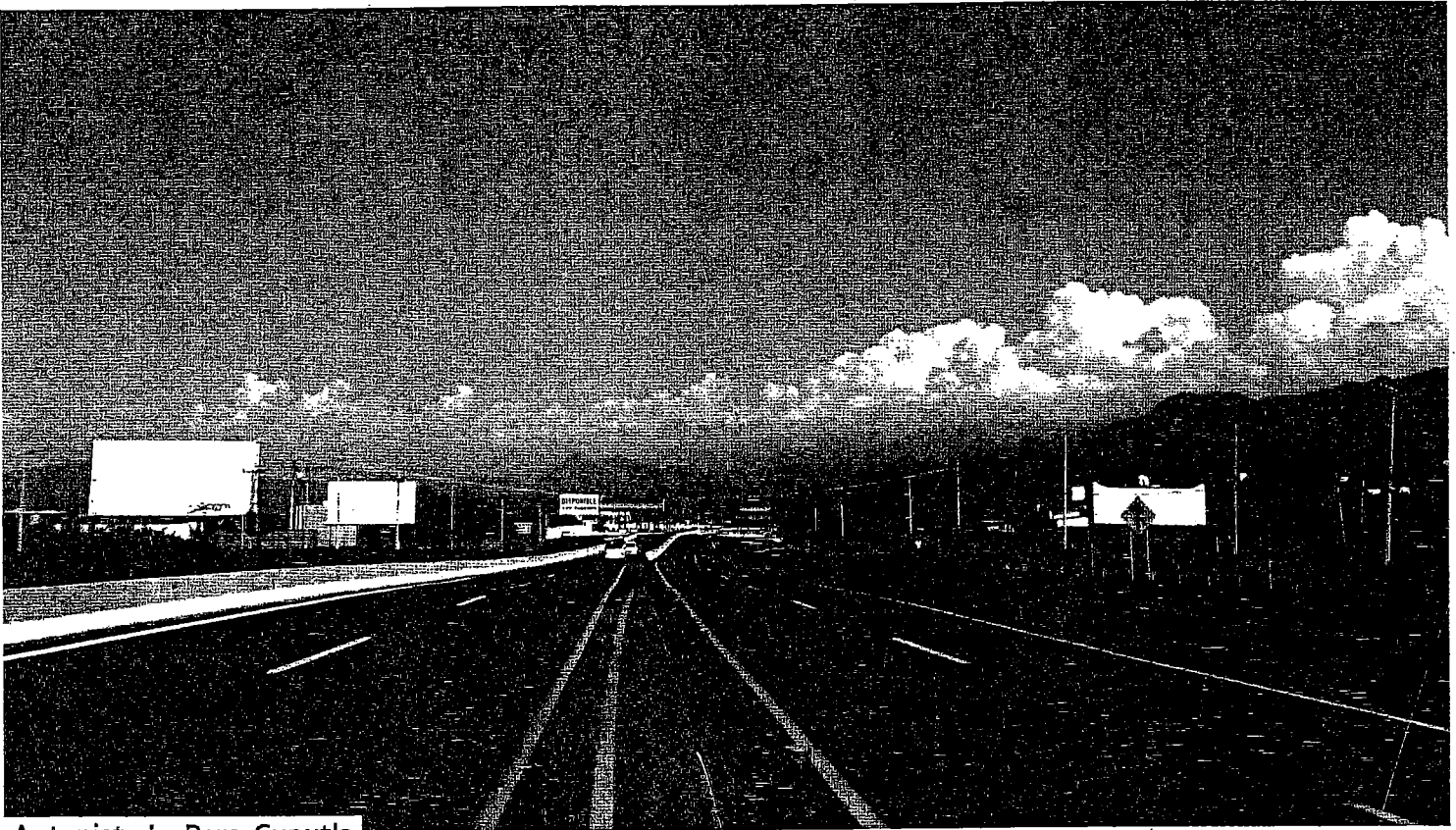
Autopista La Pera-Cuautla
