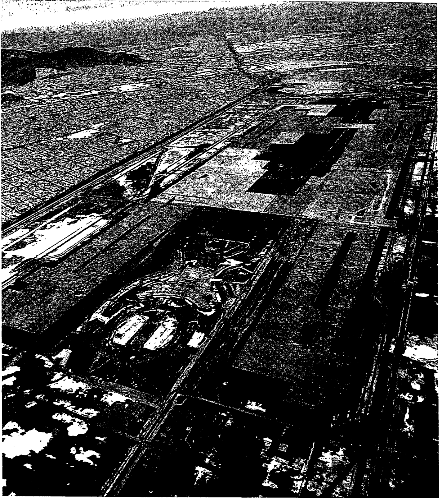
Panorámica del Edificio Terminal del Nuevo Aeropuerto Internacional de México.
