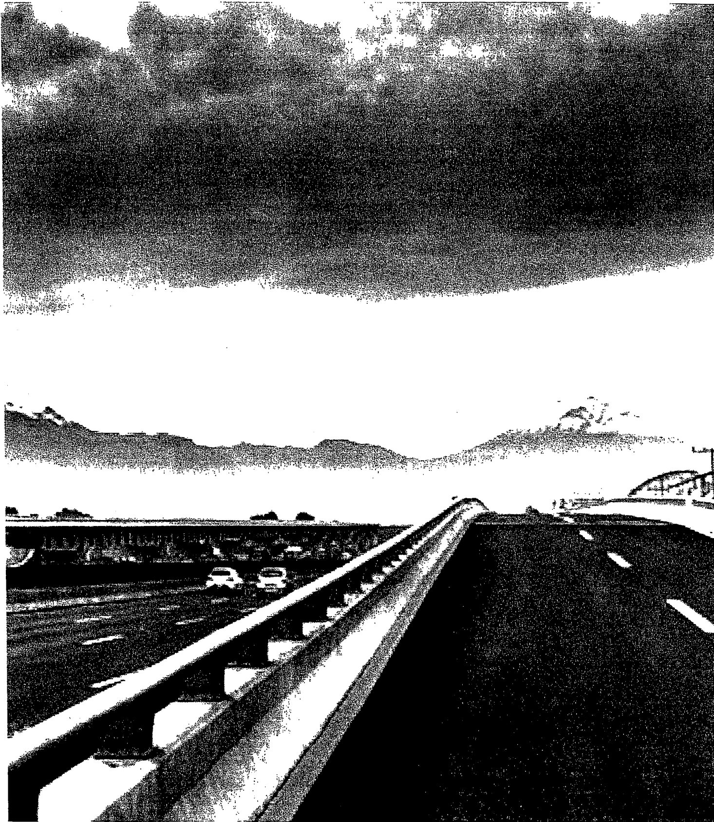
Ampliación de la autopista México-Puebla.
