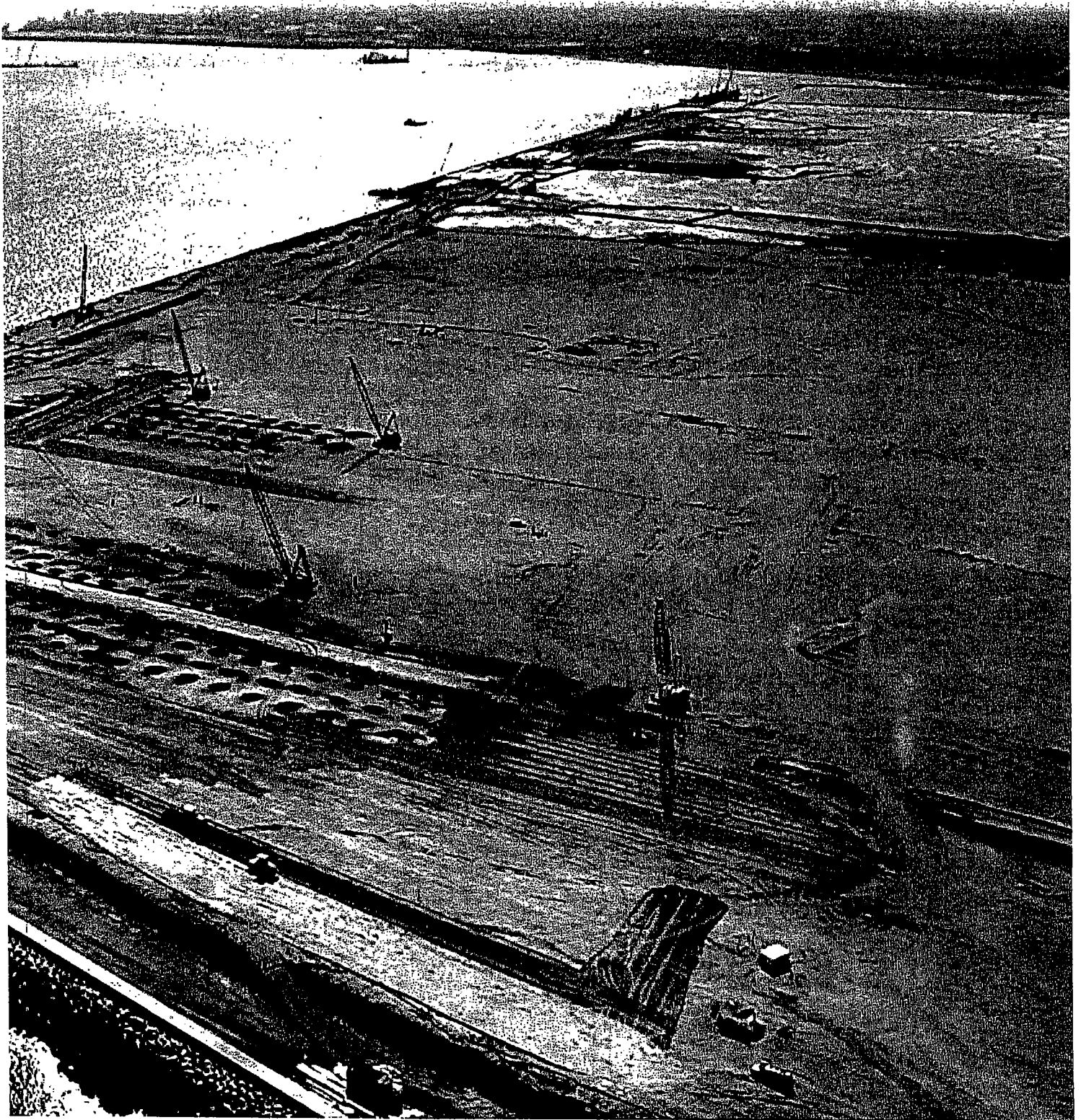
Nuevo Puerto de Veracruz. Durante el segundo semestre del año 2017 se concluyó la escollera, se avanzó en el dragado del canal de navegación y en el relleno de los muelles con lo que se alcanzó el 70% de avance general.
