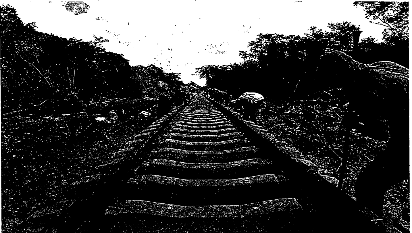
Rehabilitación de las vías del Tren Chiapas–Mayab.
