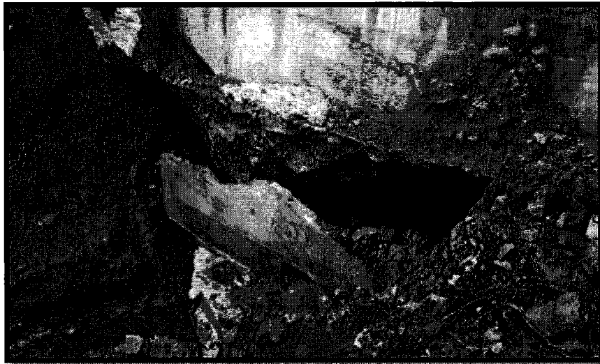
Salida de la alcantarilla aguas abajo, en la parte inferior del muro de contención, se observaron oquedades sobre el primer relleno de concreto hidráulico.
