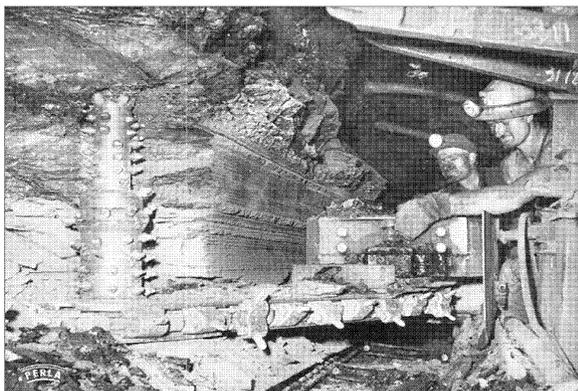
que es trabajar en 80 centímetros, pues ahí tenía que trabajar la gente, bajábamos nosotros en cuclillas, ¿por qué?, porque la parte de arriba es roca y la parte de abajo es roca, entonces, únicamente se explota el carbón. Eso les da a ustedes una idea de la incomodidad
