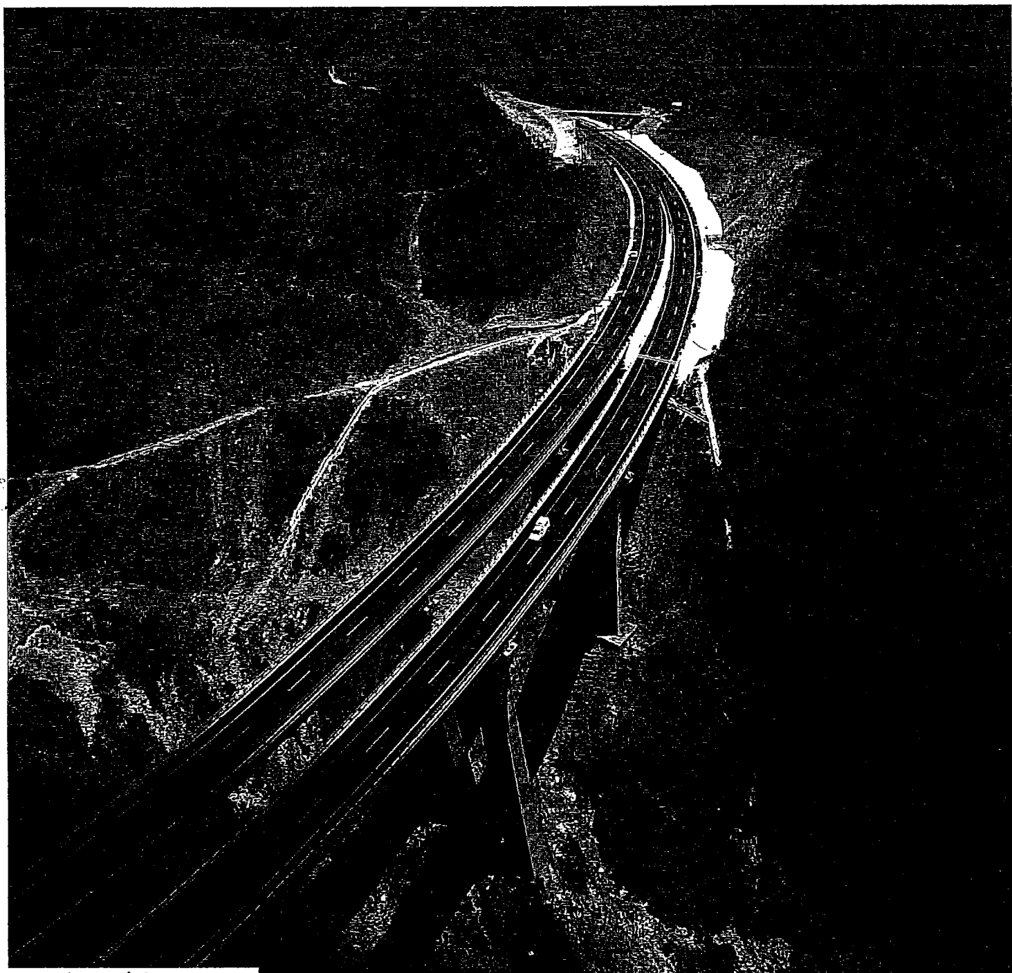
Autopista México - Tuxpan
