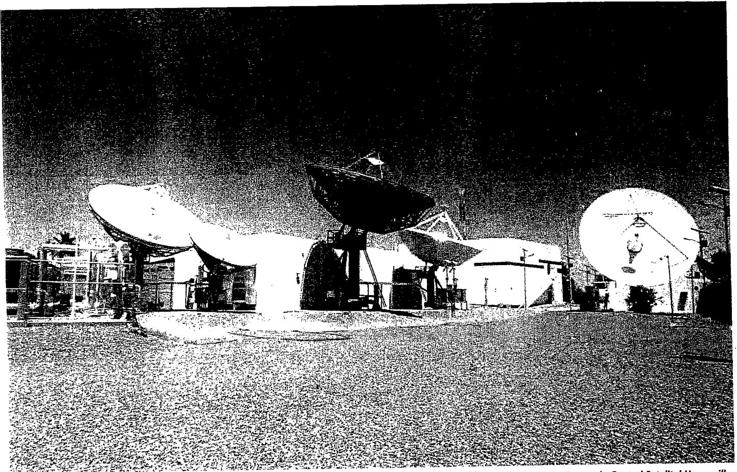
Centro de Control Satelital Hermosillo
