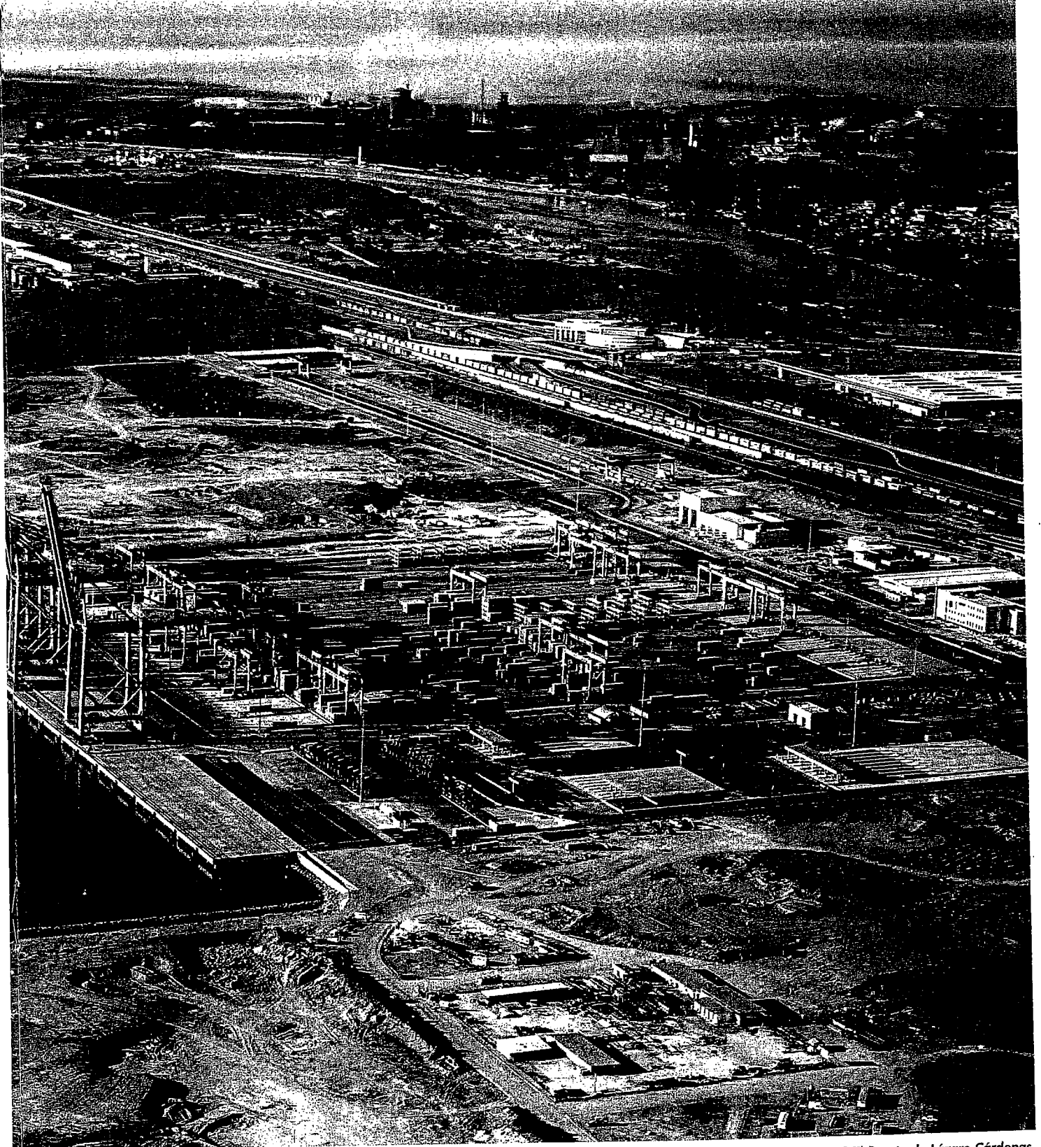
Terminal Especializada de Contenedores II (TEC II) Puerto de Lázaro Cárdenas
