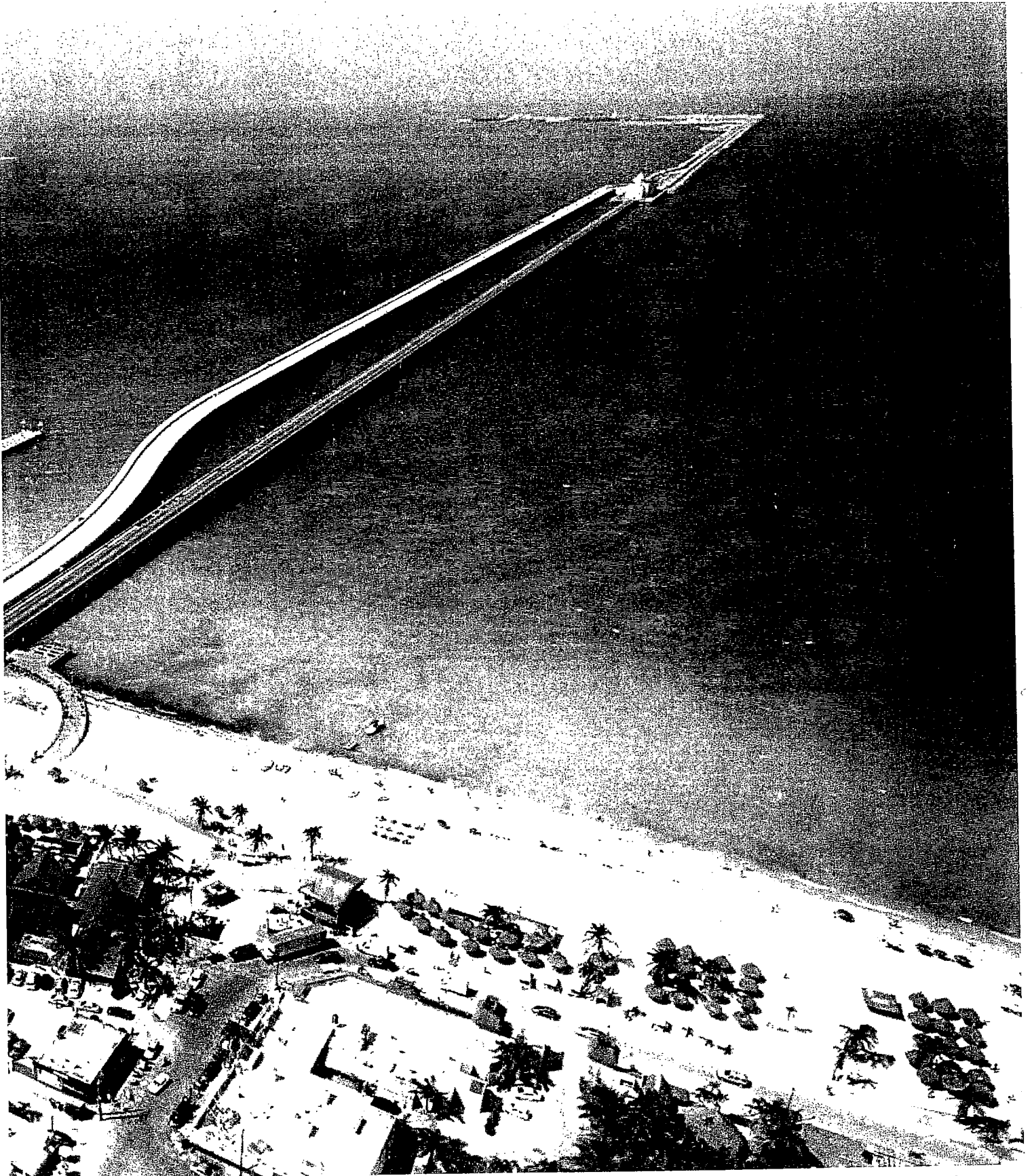
Viaducto Alterno al Puerto de Progreso
