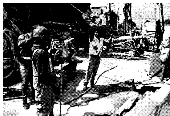
Imagen 18. Trabajadores en la realización de actividades para el mejoramiento de suelos en la Carretera Xochimilco-Tulyehualco. Fuente: twitter @SOBSECDMX
