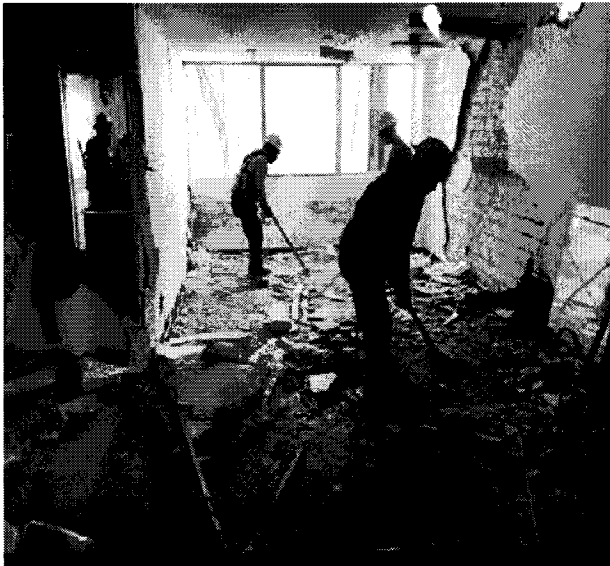
Imagen 22. Trabajos de demolición manual.
