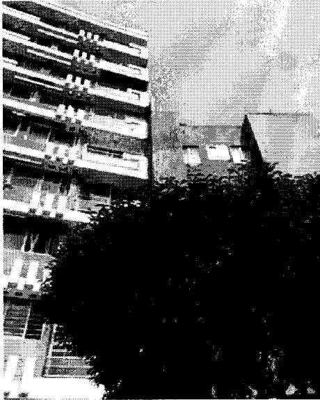
Imagen 21. Después del 19S, el edificio se "recargó" hacia la derecha, en el inmueble vecino
