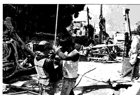
Imagen 19. Trabajadores en la realización de actividades para el mejoramiento de suelos en la Carretera Xochimilco-Tulyehualco. Fuente: twitter @SOBSECDMX
