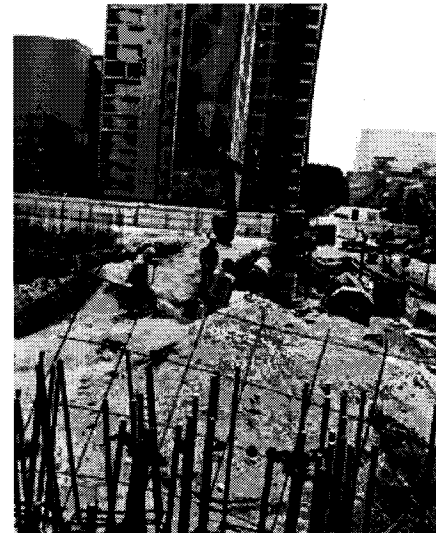
Imagen 13. Trabajos de reconstrucción del inmueble
