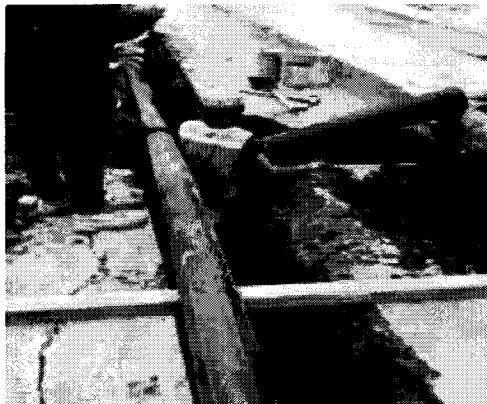
Imagen 31. Sustitución de tubería de la red de agua potable para tomas domiciliarias. Fuente: Informe de la Delegación Tláhuac.
