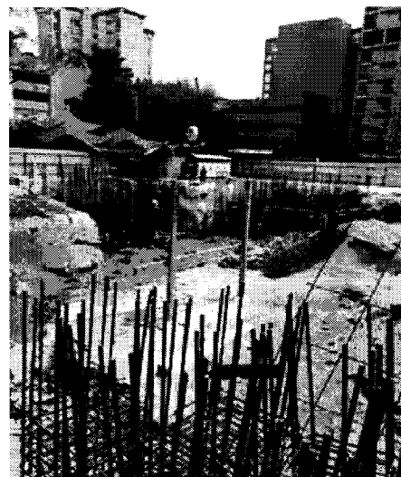
Imagen 14. Trabajos de reconstrucción del inmueble
