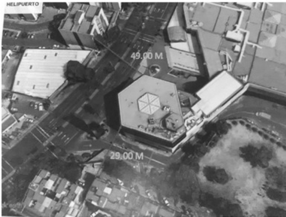
Figura 3. Helipuerto en Av. Universidad # 2014, en la Ciudad de México. Nótese la distancia que lo separa de los edificios de vivienda aledaños, en contravención a las normas internacionales de aviación civil.
