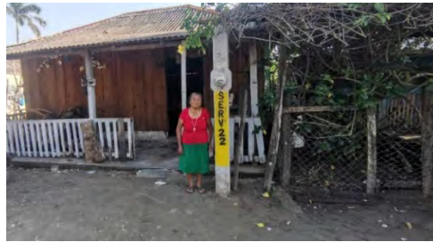
Electrificación de la localidad de Península de Atasta, municipio de San Antonio Cárdenas en el estado de Campeche.
