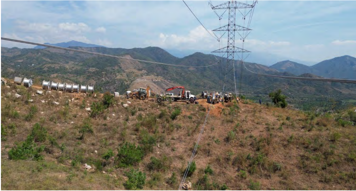
Fotografía: Tendido de cable conductor, operativo OTIS
