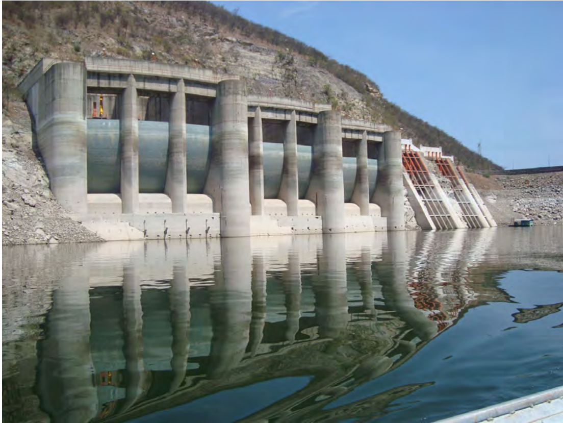
Central Hidroeléctrica Infiernillo
