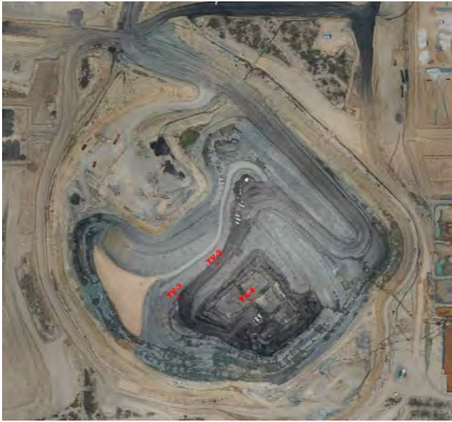
Fotografía: Vista general del tajo
