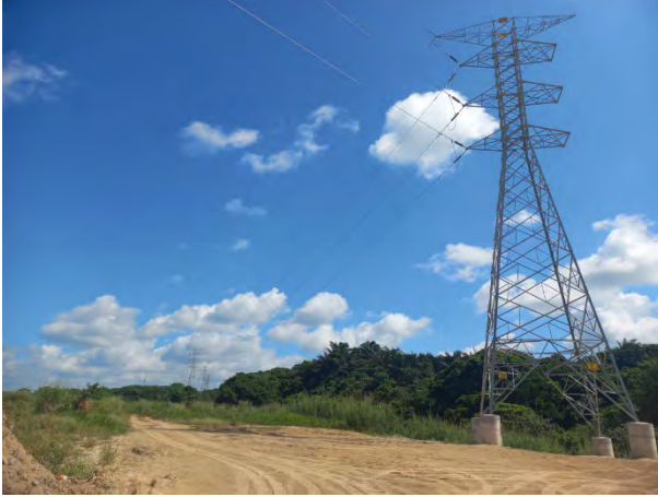
Fotografía: Trabajos de modificación de Líneas de Transmisión, en alta tensión, al interior del Puerto de Coatzacoalcos (ASIPONA)
