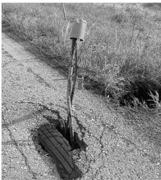
Imagen 3, carretera federal 127, tramo Alazán – Canoas
