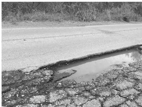
Imagen 4, carretera federal 127, tramo Alazán – Canoas
