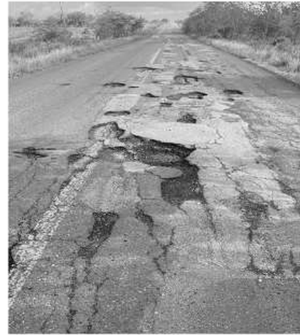
Imagen 5, carretera federal 127, tramo Alazán – Canoas
