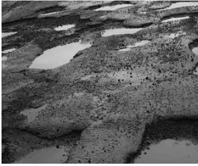
Imagen 2, carretera federal 127, tramo Alazán – Canoas
