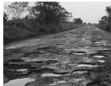
Imagen 1, carretera federal 127, tramo Alazán – Canoas
